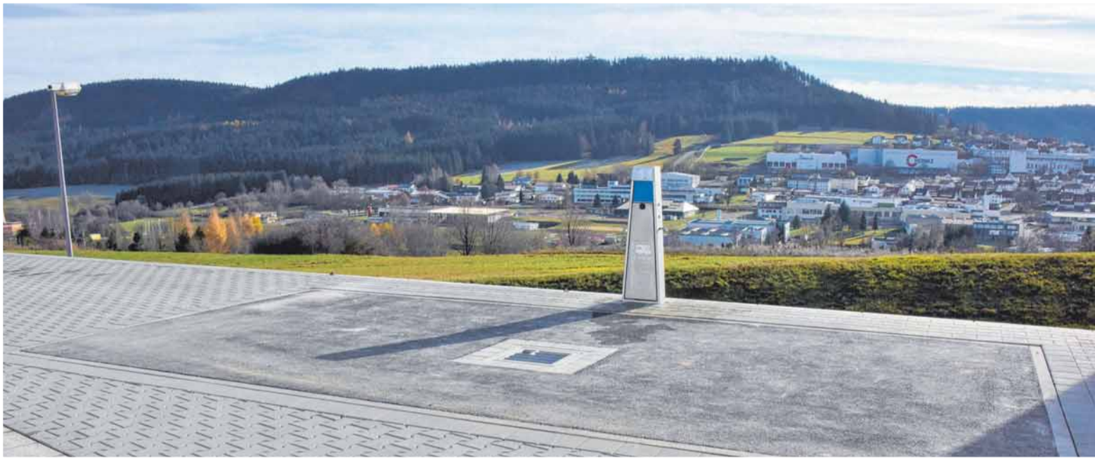
Der XXL Premium Garagenpark Gosheim besticht unter anderem mit dieser Ver- und Entsorgungsstation, an der Grauwasser- und Kassetten-WC entsorgt und gereinigt sowie Frischwasser getankt werden können - und das vor diesem Panorama. FOTO: PRIVAT
