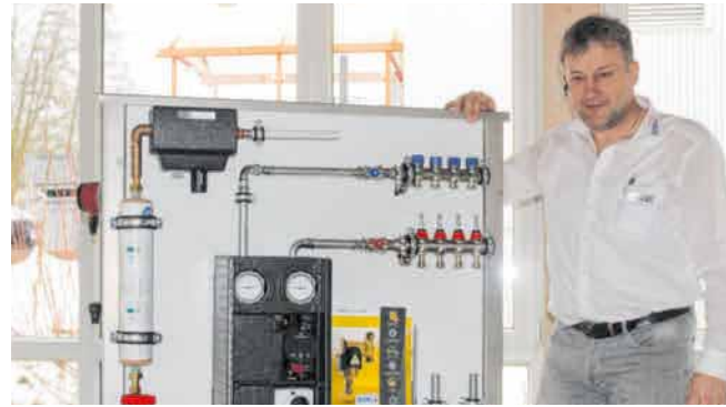
Der Trend geht in Richtung einer förderfähigen Biomasse- oder Wärmepumpenanlage: Gerd Pieper ist Heizungsbauchef bei Hermle.
