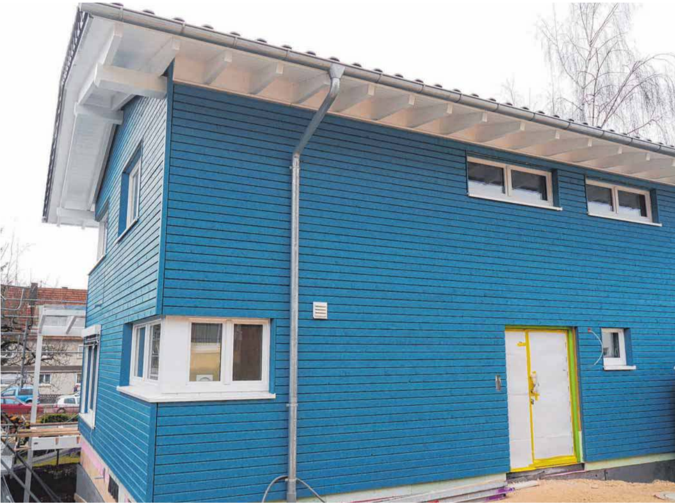
Holz ist ein uralter Baustoff, der seine Vorteile nie verloren hat - auch nicht beim Neubau von Holzbau Weiss in Spaichingen.
