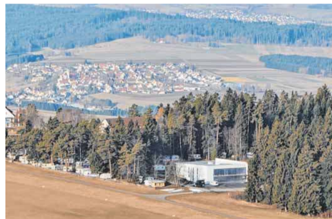
Die neue Werkstatthalle stärkt den Standort Klippeneck. FOTO: BWLV
