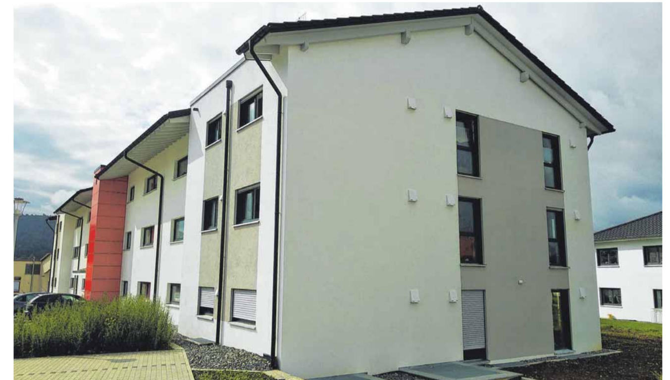
Dank der hellen Farbtöne in Weiß und Grau wirkt das Gebäude nach außen freundlich und modern. Damit passt der Neubau auch gut in den Gosheimer Ortskern. Innen finden sich die lichtdurchfluteten Wohnungen. FOTO: PM
